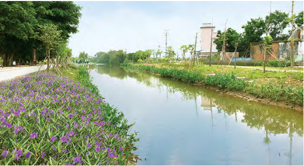
中节能铁汉珠海斗门区黑臭河涌水生态修复 PPP 项目
