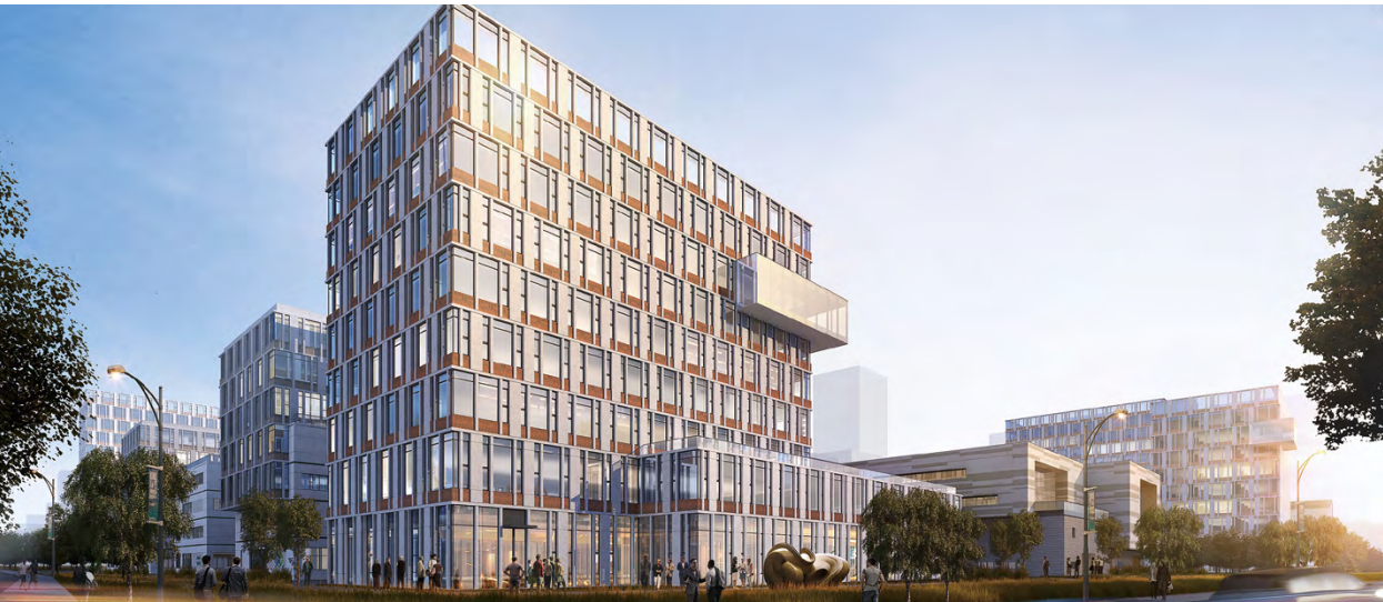
2023 年 1 月，中节能实业富阳环保产业制造基地项目荣获绿色建筑标识证书。4 月，再次荣获杭州市建设工程结构优质奖
