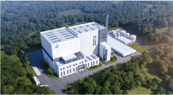
中国环保第一次自主设计和建设的小型化垃圾发电项目——平泉项目
