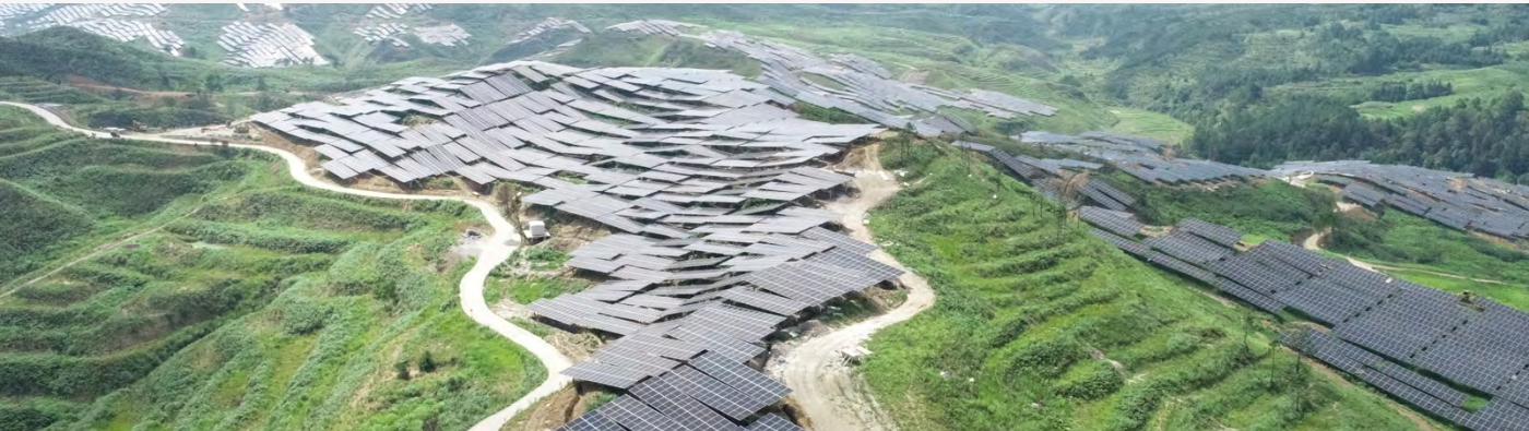
中节能荔波县甲良 200MW 农业光伏电站项目
