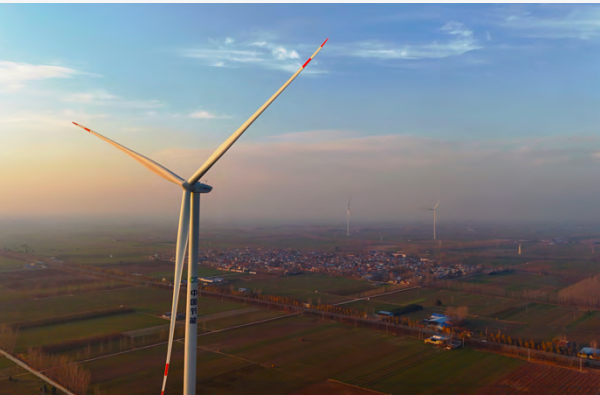
中节能永兴 50 兆瓦风力发电项目
