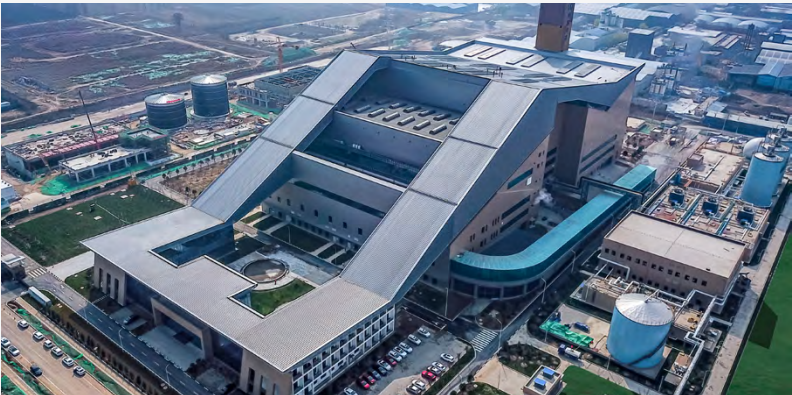
西安市鄠邑区生活垃圾无害化处理焚烧热电联产项目
